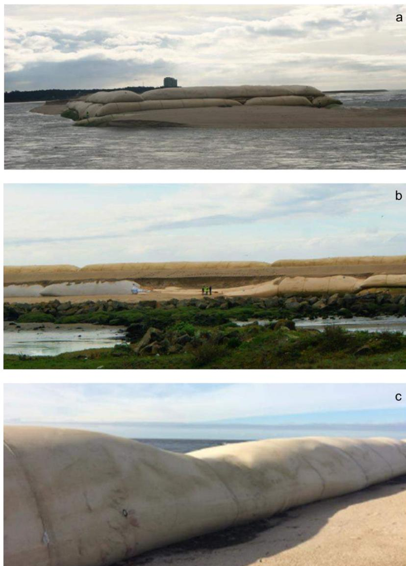
**Figura 20 - Exemplos de problemas encontrados nos geocilindros face aos fenómenos marítimos e fluviais, no início de 2016 [2].**
