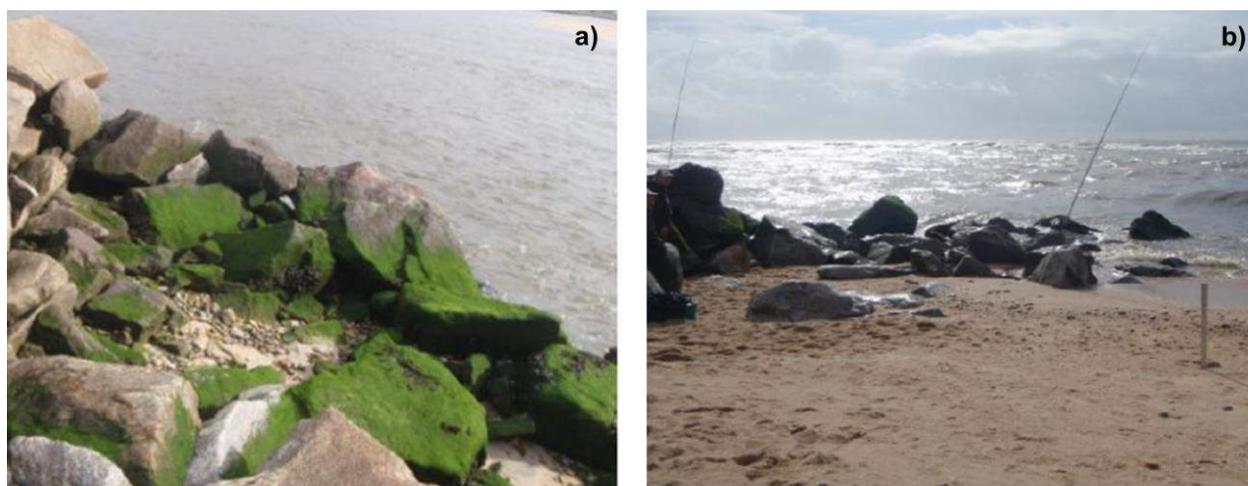
**Figura 22 - Molhe norte da embocadura do rio Cávado, estado de degradação da estrutura de enrocamento: a) falhas na estrutura (vista norte), b) destruição na secção da cabeça (vista norte) [5].**
