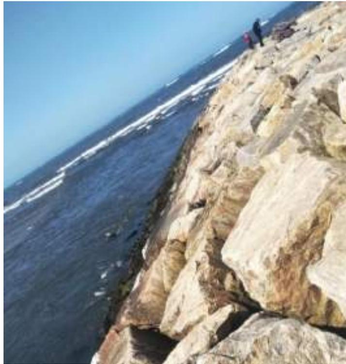
**Figura 24 - Talude de enrocamento do quebramar norte, maio de 2020.**
