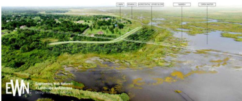
Figura 86 - Dique horizontal com um talude suave (e.g. 1V:30H) para possibilitar a migração de habitat ao longo do talude (adaptado de Engineering With Nature).
