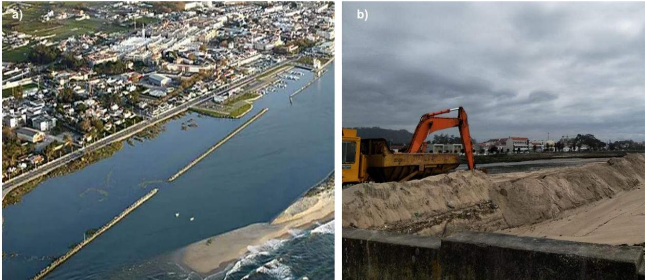
**Figura 27 - Intervenção no dique da foz do rio Cávado: a) resultado do galgamento e inundações devido às marés associadas a períodos de agitação marítima intensa na secção entre os diques e o muro marginal de Esposende; b) obras de intervenção no dique [4].**
