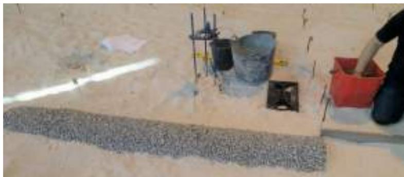
Figura 142 – Dique longitudinal: construção com as diferentes camadas de enrocamento.
