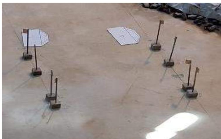
Figura 134 – Varetas de nível e moldes para a construção de estruturas fixas.
