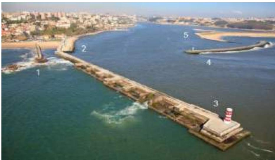
**Figura 37 - Fotografia aérea da embocadura do rio Douro: 1) molhe de Felgueiras; 2) molhe do Touro; 3) molhe norte; 4) quebramar destacado; 5) cabedelo [4].**
