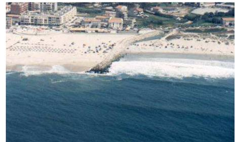
Os esporões inicialmente interceptam parcialmente o transporte longitudinal que se verifica de Norte para Sul, reflectindo-se na acumulação a Norte do esporão e erosão a Sul. Uma vez que parte do material aluvionar é retido a Norte, a acumulação de areias no esporão seguinte é conseguida com a erosão dos maciços dunares a Sul dos esporões.
