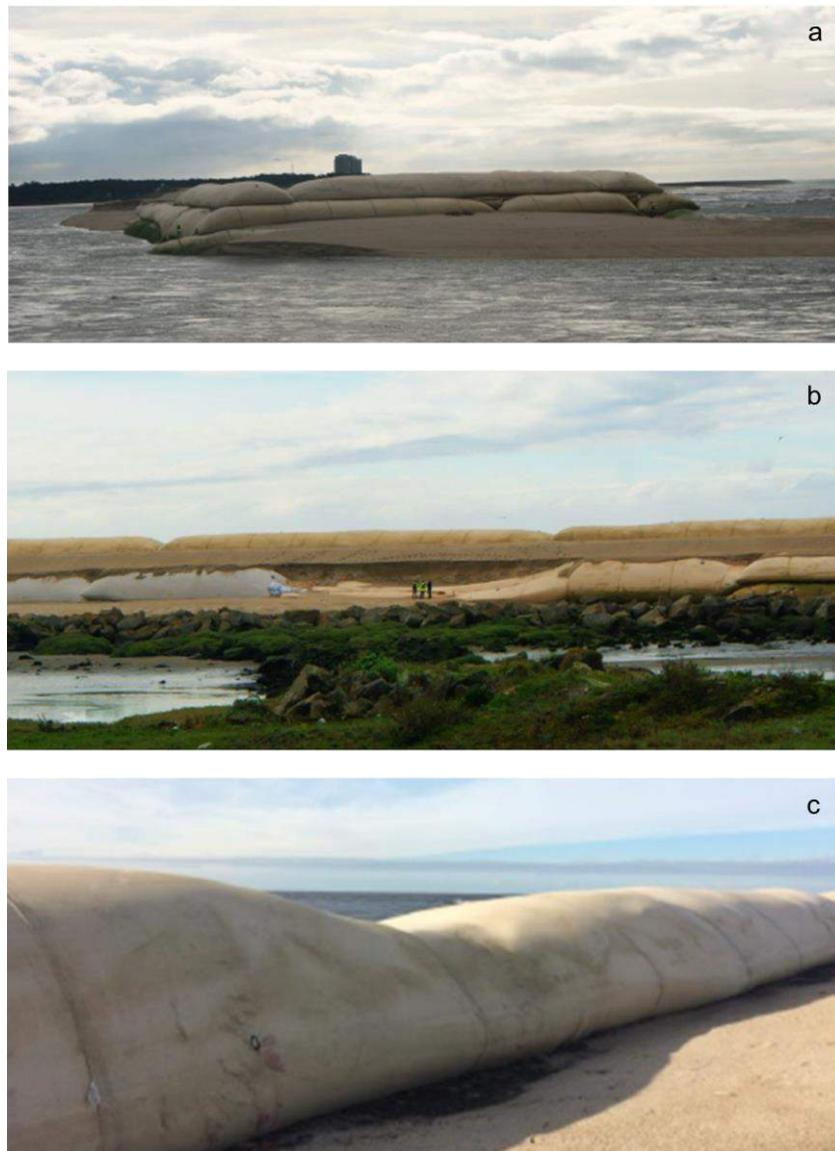
**Figura 20 - Exemplos de problemas encontrados nos geocilindros face aos fenómenos marítimos e fluviais, no início de 2016 [2].**
